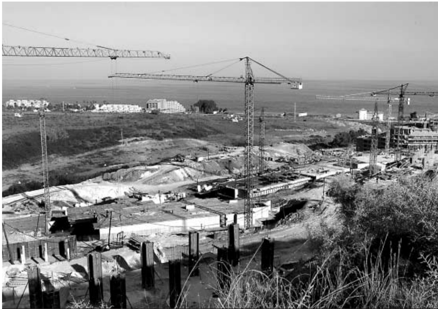
OBRAS. Vista del término municipal de Manilva con unas obras de construcción de pisos en primer plano.
